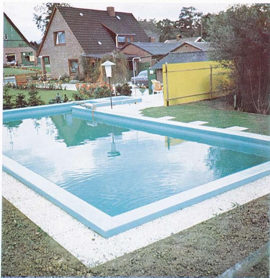
Dieses Becken ( $10 \times 5 \times 1,50$  m) wurde nach der Spanplatten-Methode erstellt. Die Aussparung auf einer Seite wurde als Treppe ausgebildet. Vor der Treppe ist eine Duschwanne mit Brause installiert. Die Umrahmung besteht aus Waschbeton-Gehwegplatten. Der etwas erhöhte Rand ist günstig gegen hereinwehende Blätter und Staub.
