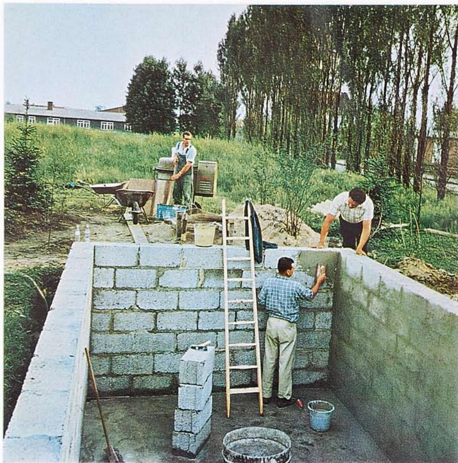
Die Hohlblocksteine werden verputzt und abgerieben. Die obere scharfe Kante wird durch Mörtel abgerundet. Radius mindestens 20 mm.
