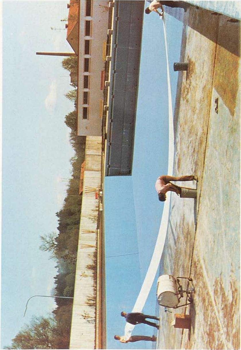
Sanierung der städtischen Badeanstalt in Kolbermoor/Rosenheim mit 3 Lagen Glasmatte und Polyesterharz. Zuerst wurde der Rand beschichtet. Die Bodenbeschichtung wird streifenweise naß-in-naß eingebracht.
