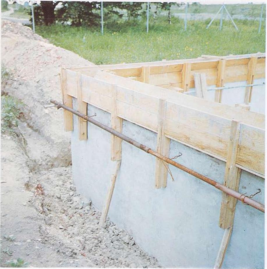
Wird Beton verwendet, so baut man eine Form aus Schalbrettern. Die Schalbrettwände werden über Drähte und Rohre sorgfältig abgestützt, damit sie ihre Lage auch unter dem Druck des Betons nicht verändern.
