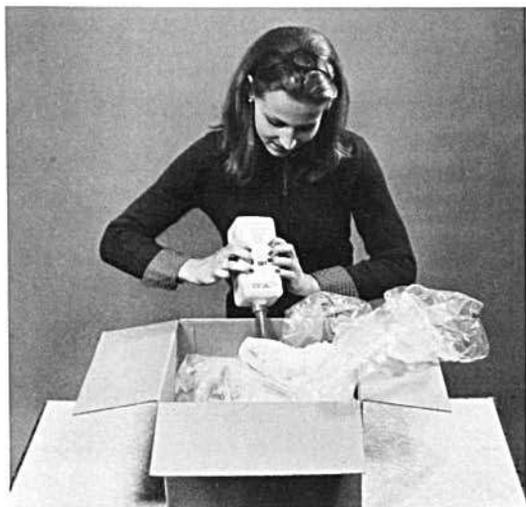
3) Die obere Verpackung wird nach Abdecken des Teiles mit Folie aus einer zweiten Packung Schüttelschaum geschäumt. Die Folie wird über dem aufsteigenden Schaum zusammengelegt und der Karton verschlossen.
