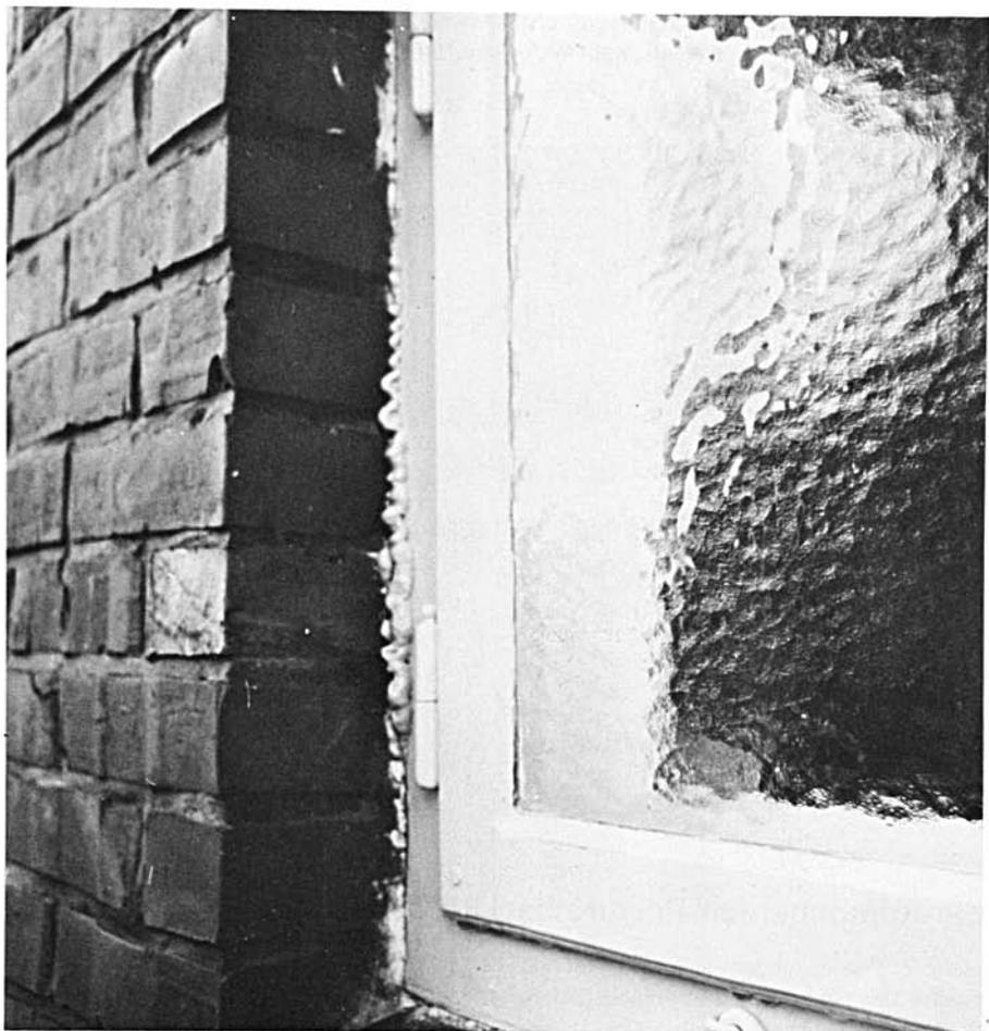
1) Ausschäumen der Anschlußfuge zwischen Fensterrahmen und Mauerwerk mit UNOVOSS verhindert die Ausbildung einer Kältebrücke.
