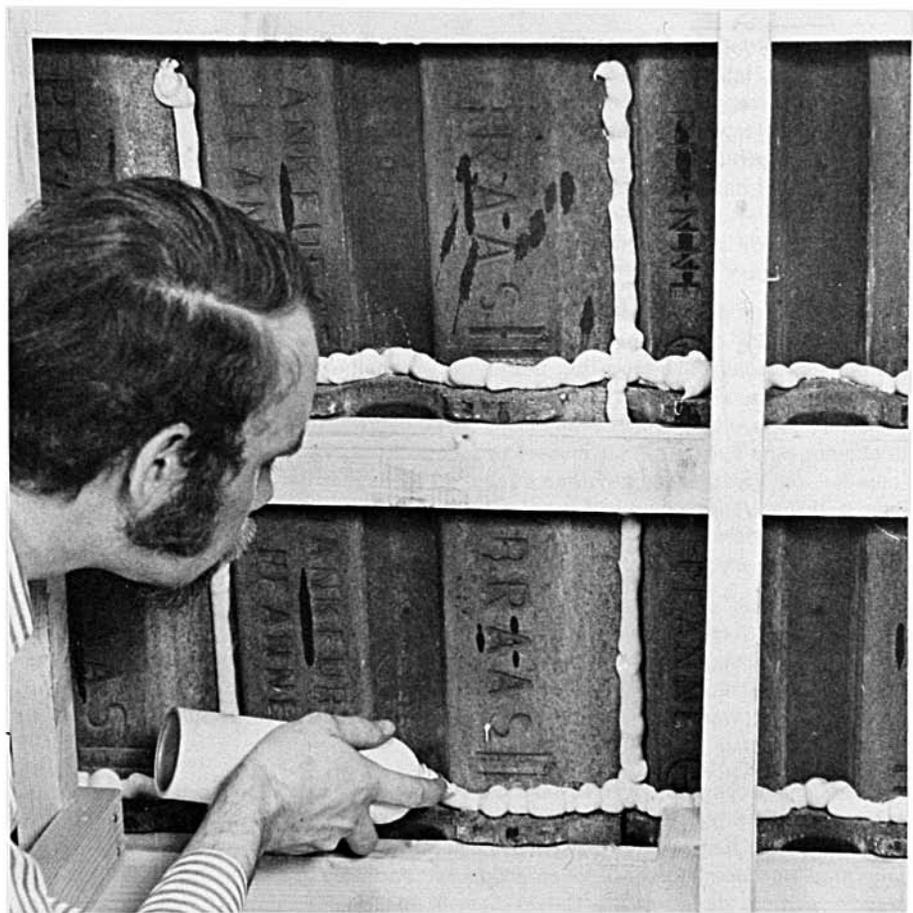
2) Hier werden die Fugen zwischen den Dachpfannen mit UNOVOSS zugeschäumt. Heizkostensparnis und ein sauberer Dachboden sind das Resultat.
