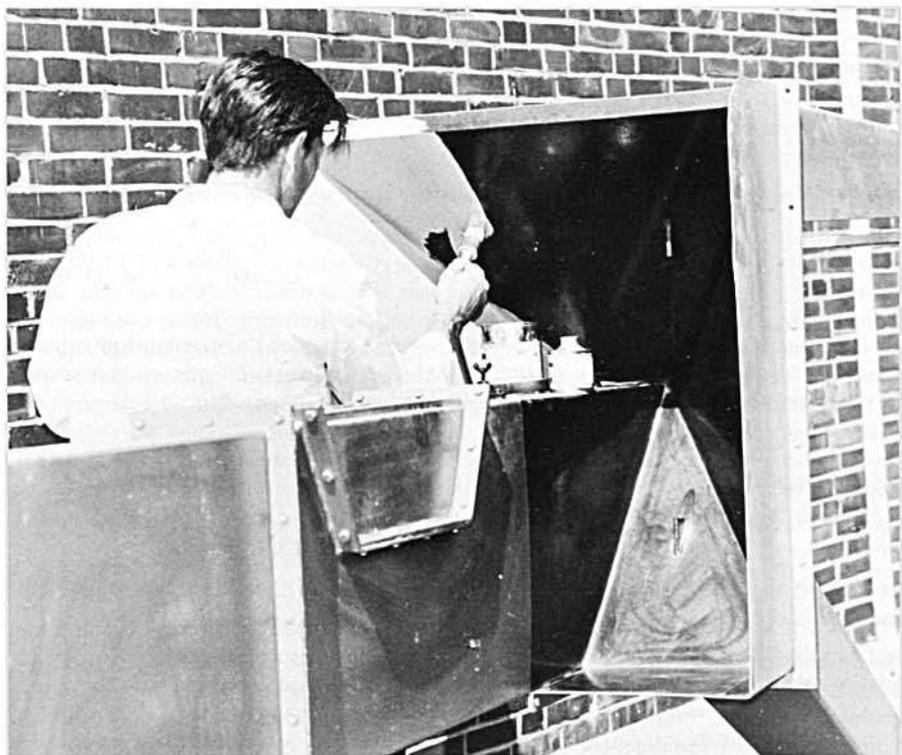
Beschichtung eines Becherwerk-Trichters mit FLEXOVOSS K 6 T. Diese Dickbeschichtung bewährt sich besonders bei Maschinenteilen, die mit abrasiven Füllstoffen in Berührung kommen. Bei Maschinen, die kleineren Stoßbelastungen unterworfen sind, wird K 6 ebenfalls erfolgreich eingesetzt. Die Masse ist thixotrop eingestellt und daher auch überkopf verarbeitbar. Der Untergrund wurde zuvor mit P-3-Lauge gereinigt und kann ggf. mit einem Rostprimer ausgerüstet werden.
