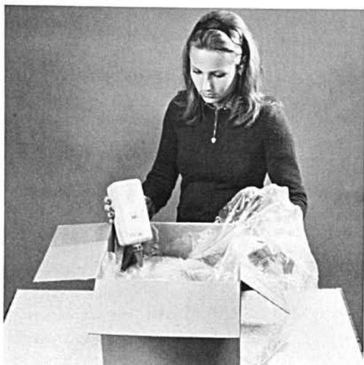
1) Aus der Handspritzflasche expandiert der Verpackungsschaum in den mit Folie ausgelegten Karton.
