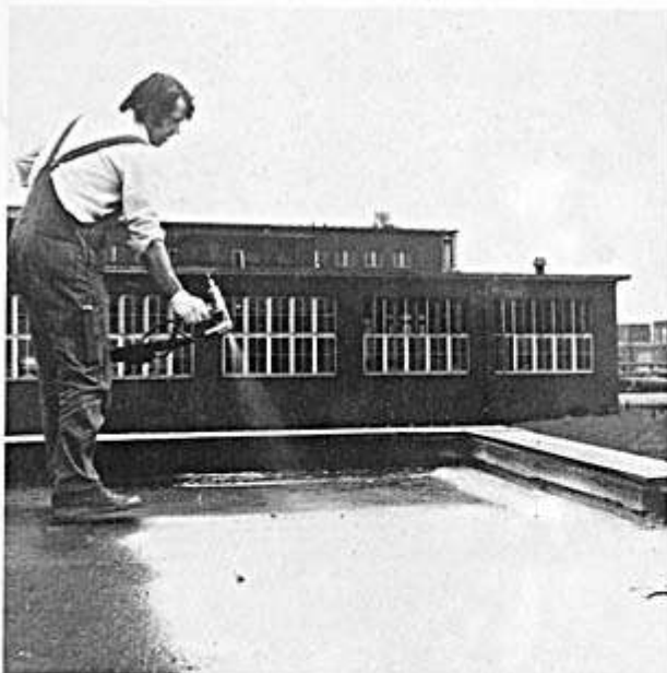
Fugenlose Dämmung und Abdichtung von Dächern mit Polyurethan-Spritzschaum
