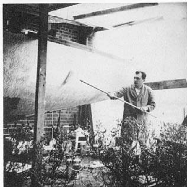
Die Farbversiegelung wird aufgerollt
