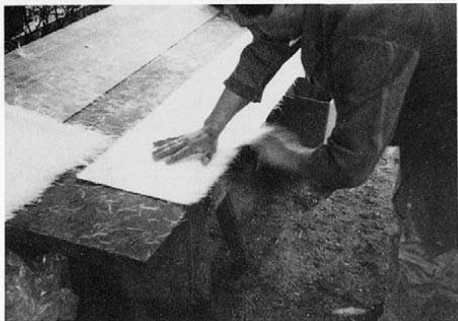
Zumessen und Vorbereiten der Verstärkungsmittel
